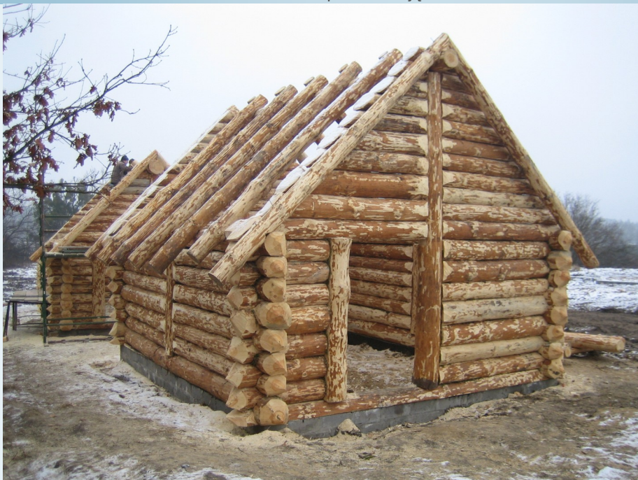
FOT. ŚREDNIOWIECZNE GRODZISKO W OWIDZU - prace trwają
